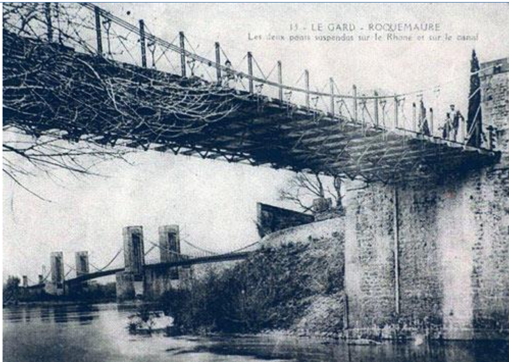
Les deux ponts suspendus sur le Rhône et sur le canal.
