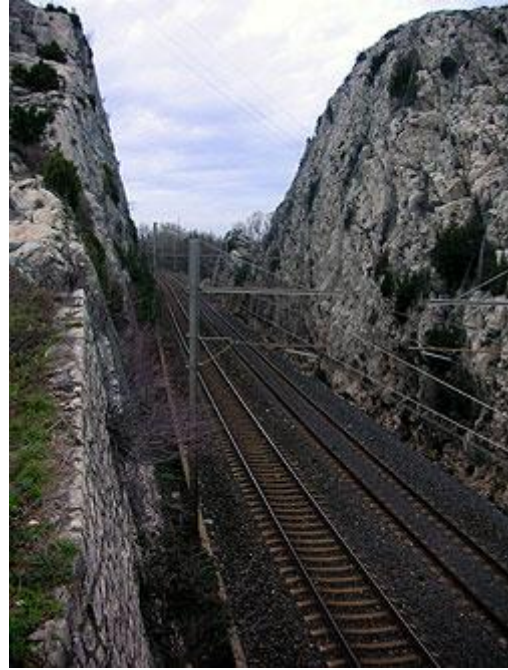
Tranchée SNCF : cette tranchée permis le passage des déportés sans être vus.
