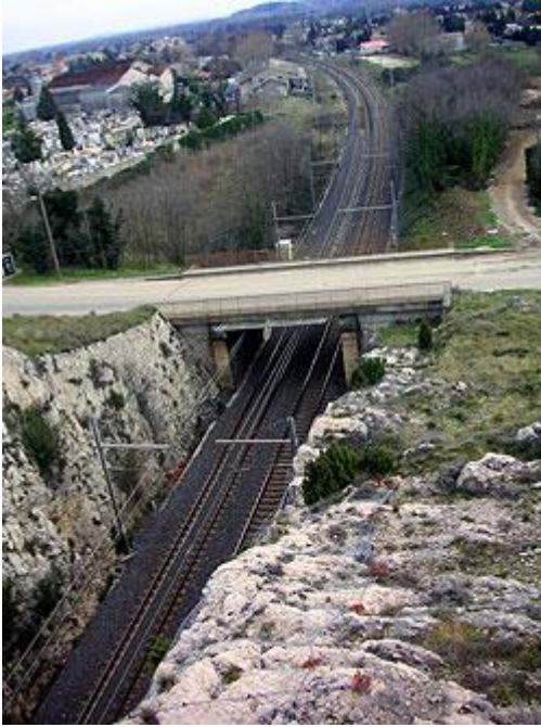
Emplacement du TF : depuis le petit pont du chemin de fer (en haut de la photo où la voie disparaît à l'horizon) jusqu'à la sortie Nord de la tranchée SNCF.
