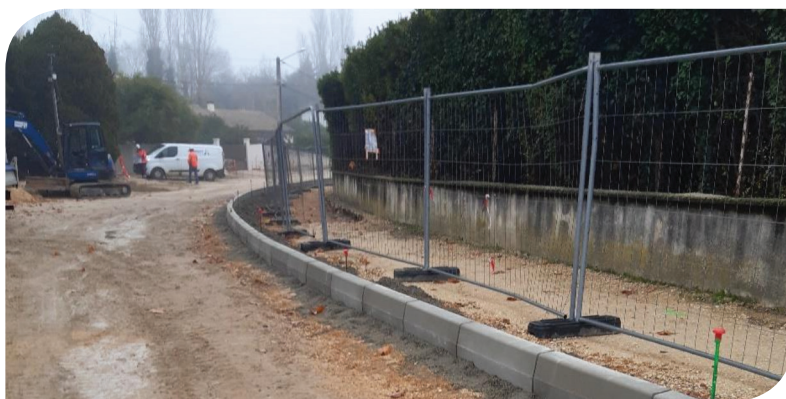
Travaux route d'Avignon
