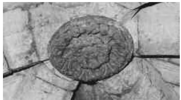
fig. 15 : La tour Ronde. Clef de voûte. © F. Lepeltier.
