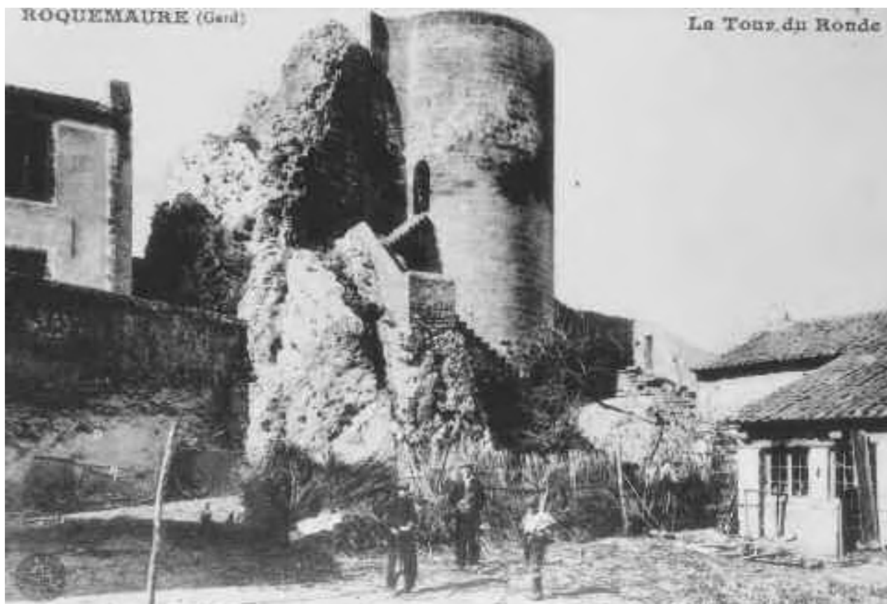
fig. 11 : La tour Ronde. Vestiges vus de la basse-cour. Carte postale, v. 1930.
