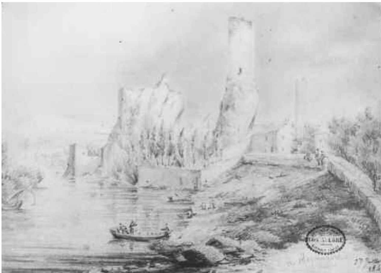
fig. 9 : L. Alègre, Roquemaure , 27 juillet 1845, dessin au crayon sur papier. Le château en cours de destruction. © C. Maigret.
