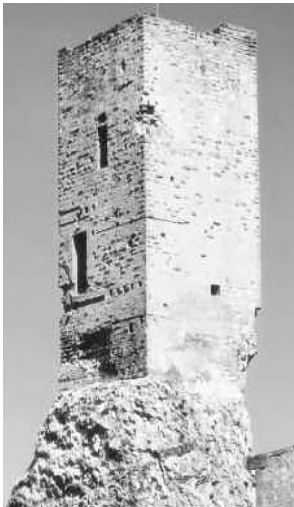
fig. 2 : La tour Carrée, faces sud et est sur le rocher éclaté à la mine. © M. Pin.
