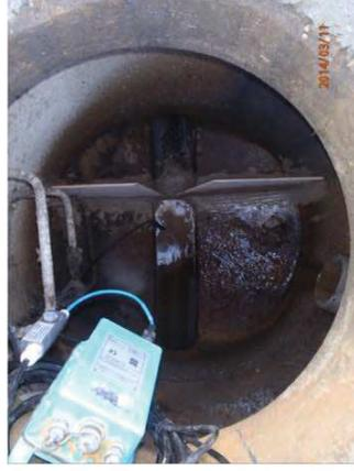
Mise en place de matériel de mesure de débit dans les réseaux
