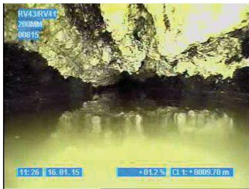
*Flaches et dépôts de graisses important dans le rue de la Fraternité*
